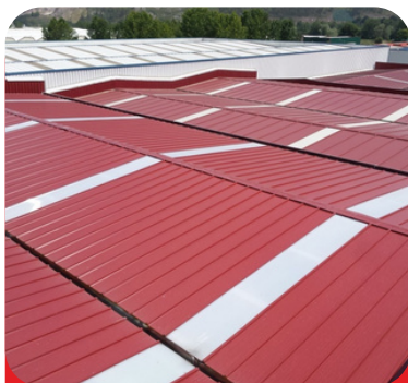
Cubierta de chapa simple
