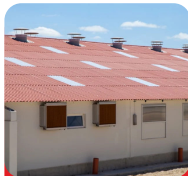
Cubierta de fibrocemento
