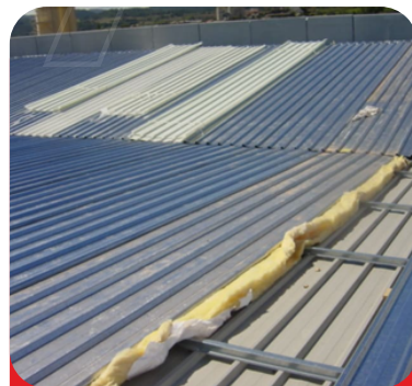
Cubierta sándwich in situ
