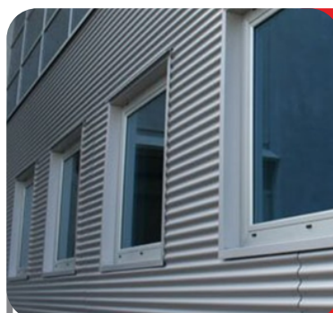
Fachada de chapa minionda
