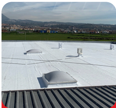
Cubierta tipo Deck
